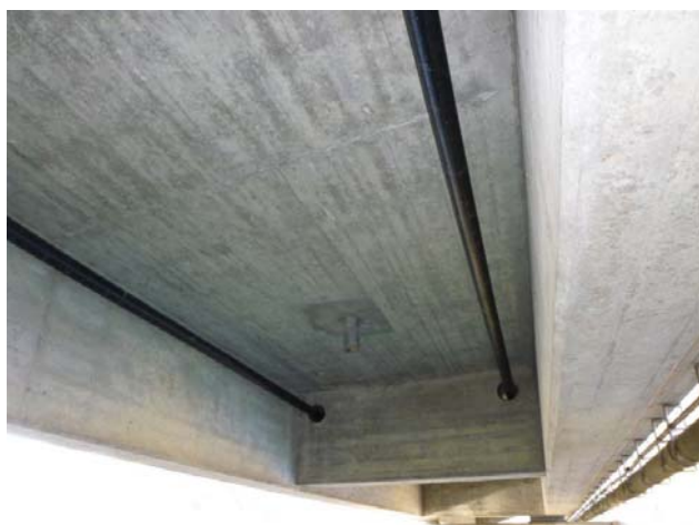
Vyměnitelné kabely externího předpětí, úspěšné zvýšení zatížitelnosti mostu
